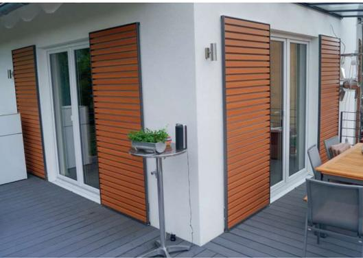
*Besonders filigrane Optik: Alle Beschlagelemente sind miniaturisiert und die untere Laufschiene wird bei Türläden in der Regel in den Boden eingelassen.*
