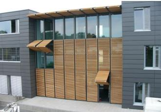
Während bereits seit mehreren Jahren an der Konzeption der Solarfassade entwickelt und bereits ein Patent angemeldet wurde, bot sich nun die Möglichkeit dieses System erstmals in die Realität umzusetzen. Ein Sonnenschutz aus unbehandelten Leisten in Douglasie konnte an einem Bürogebäude angebracht werden. Dank einer überaus experimentierfreudingen Bauherrin konnte dieses Projekt in Gütersloh realisiert werden.
