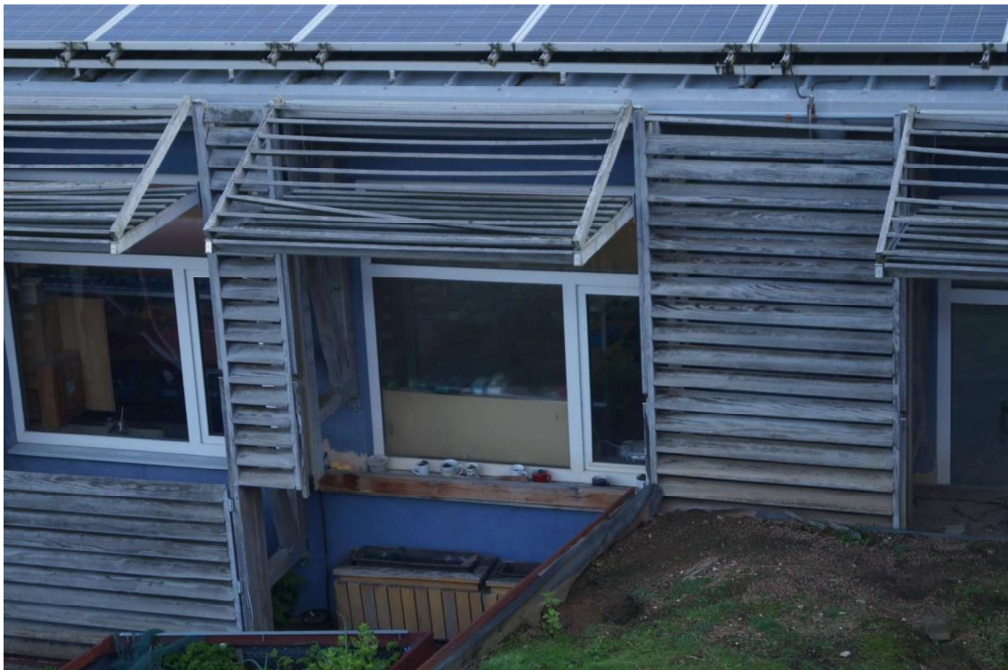
Abb.38: T-Verbindung von Jalousien haben sich gelöst
