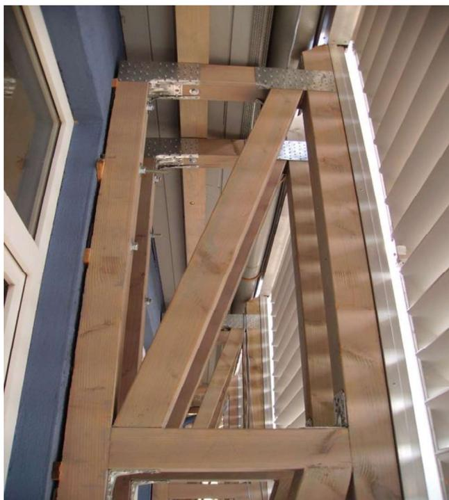
Abb. 7: Tragkonstruktion der vorgehängten Fassade; Werkbild hilbra
