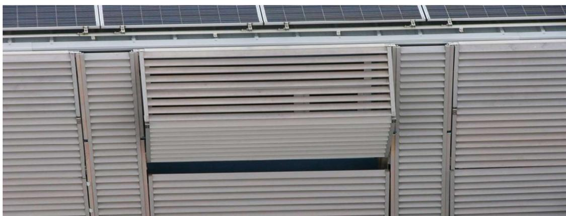
**Abb. 10:** Teilweise geöffneter Horizontalfaltladen; Werkbild hilbra
