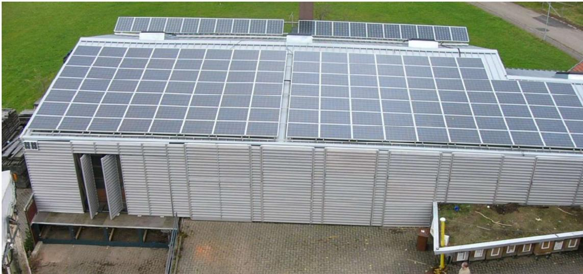
**Abb. 4: Testfassade mit sich öffnenden Wendeläden; Werkbild hilbra**
