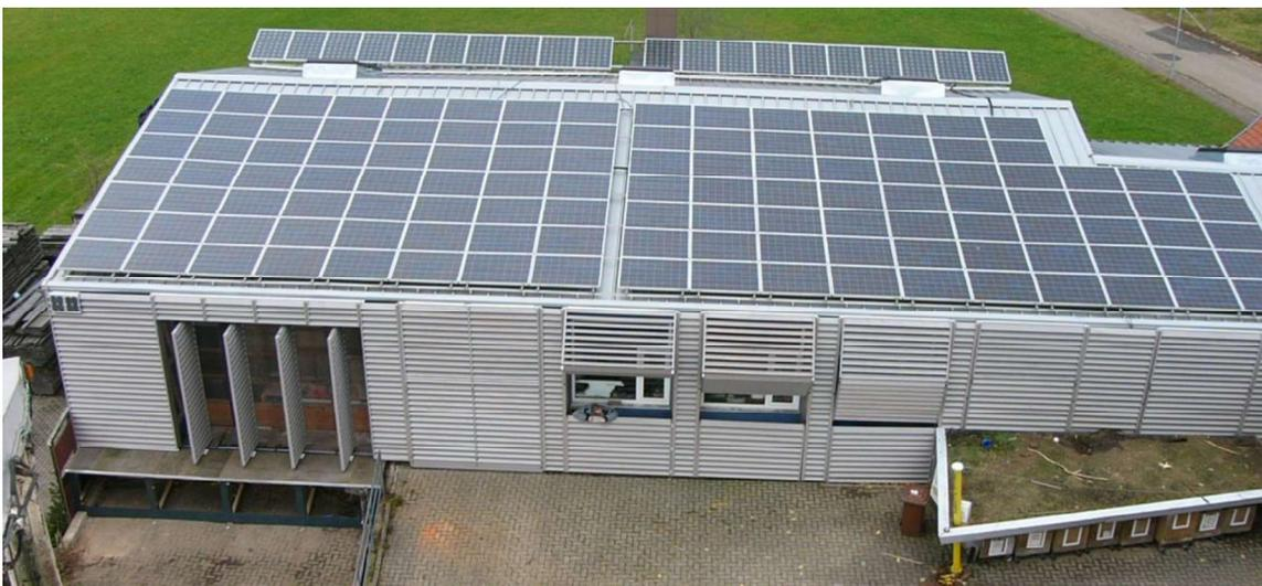
**Abb. 5: Testfassade mit geöffneten Wendeläden und teilweise geöffneten Horizontalfaltläden; Werkbild hilbra**
