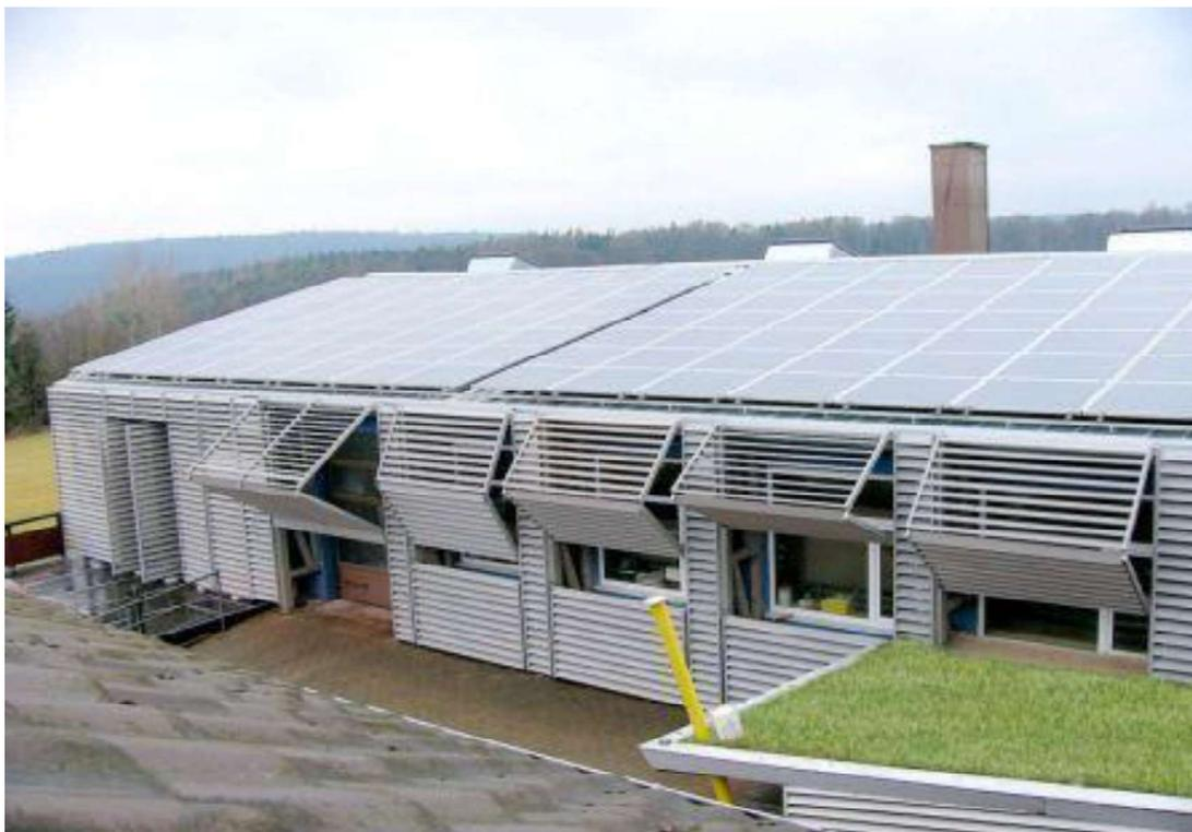
**Abb. 9: Manuelle Drehläden im Brüstungsbereich unter HFL; Werkbild hilbra**
