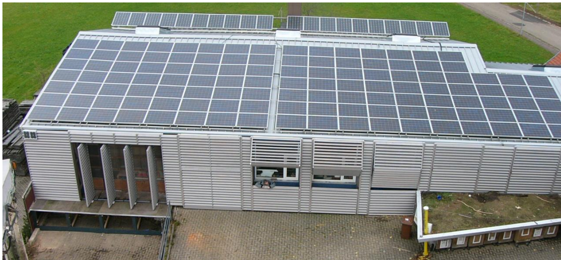
Abb. 2: Testfassade mit geöffneten Wendeläden und teilweise geöffneten Horizontalfaltläden; Werkbild hilbra
