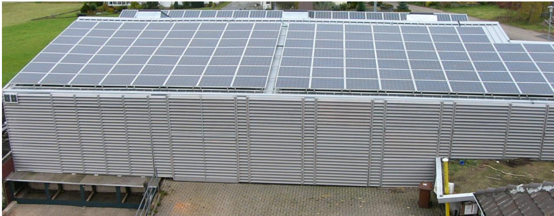
Abb. 1: Testfassade geschlossen; Werkbild hilbra
